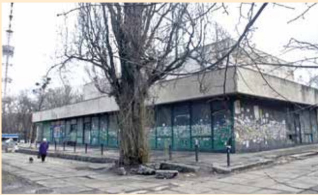
Комісія КМДА оглянула приміщення
